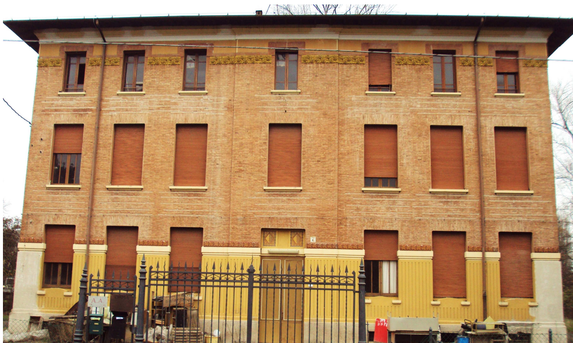
Veduta della ex-scuola elementare di S. Marino di Carpi.
