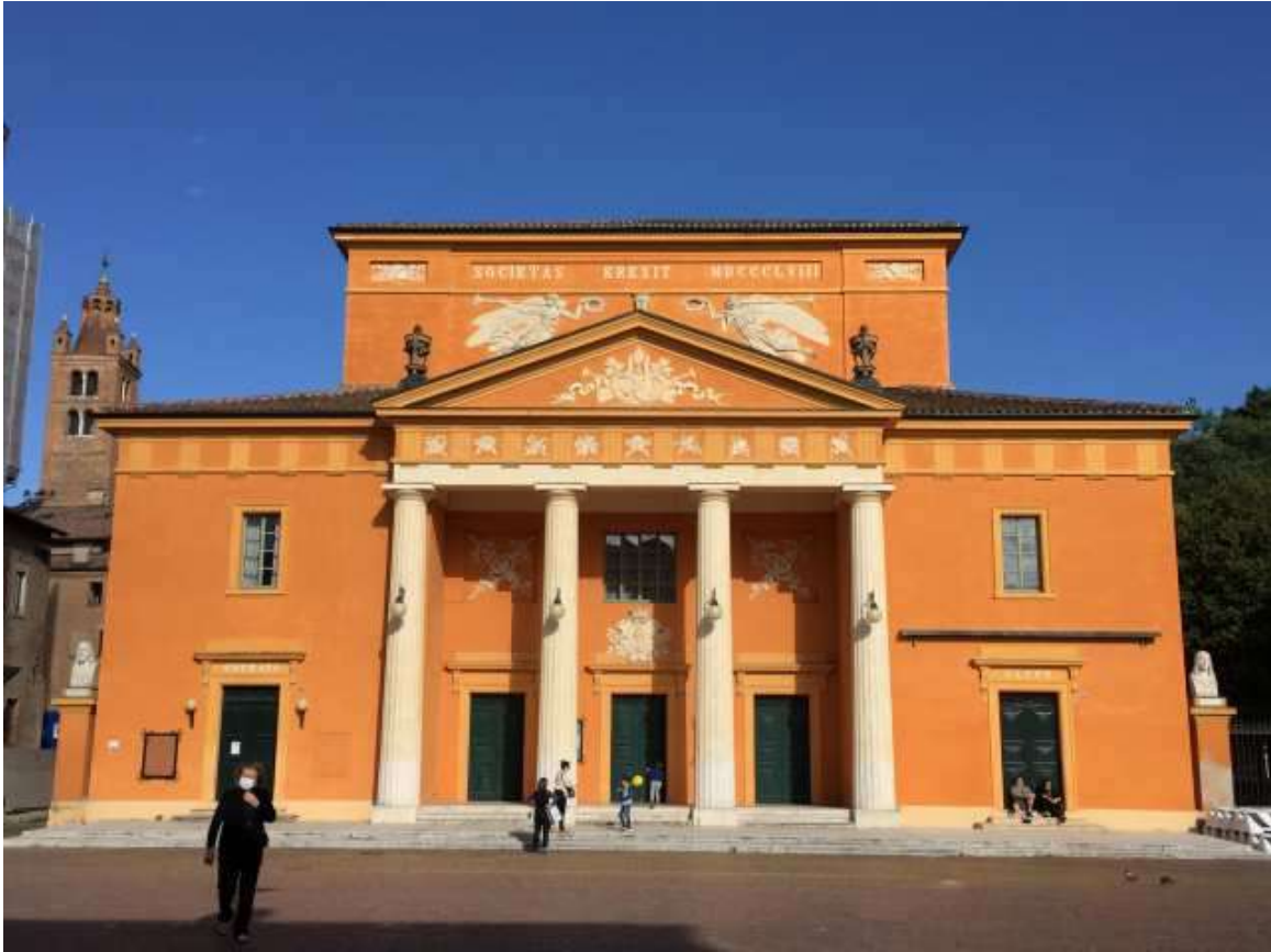
FACCIATA OVEST SU PIAZZA DEI MARTIRI
