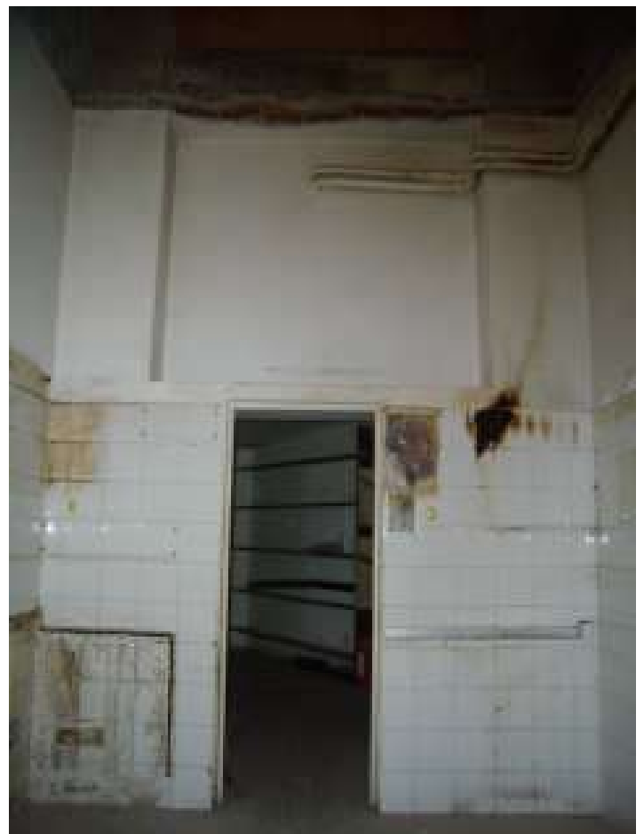
PARETE NORD VERSO IL DISIMPEGNO
