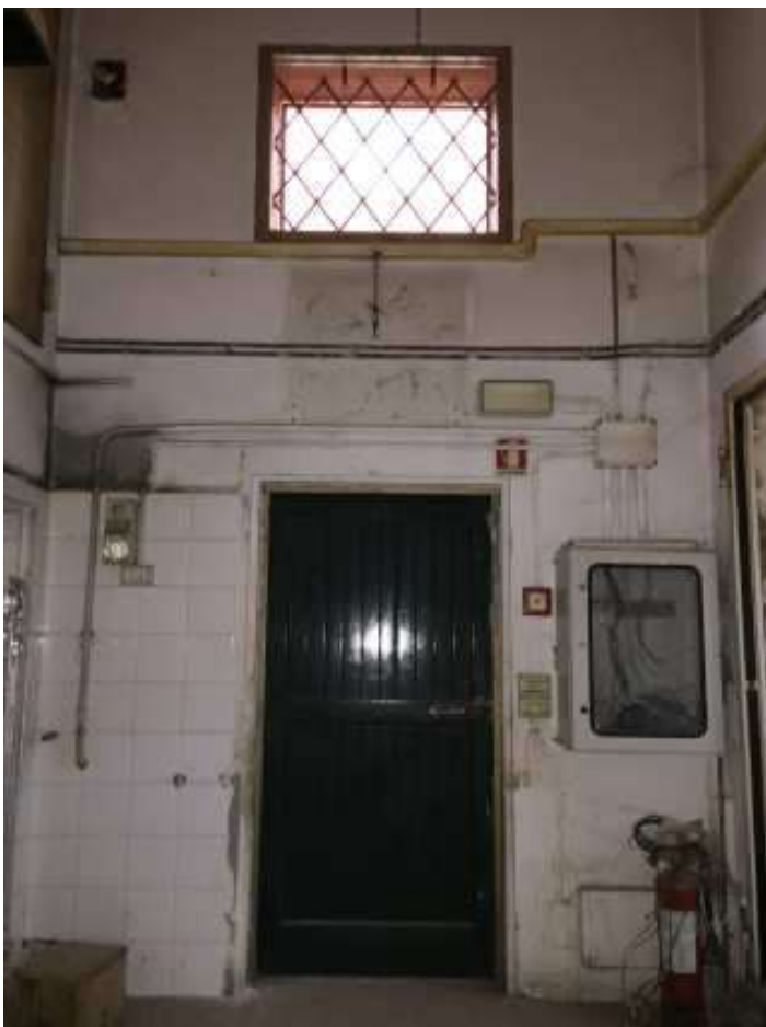
PARETE SUD CON PORTA VERSO L'ESTERNO
