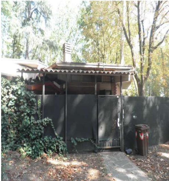
TETTOIA A SUD
