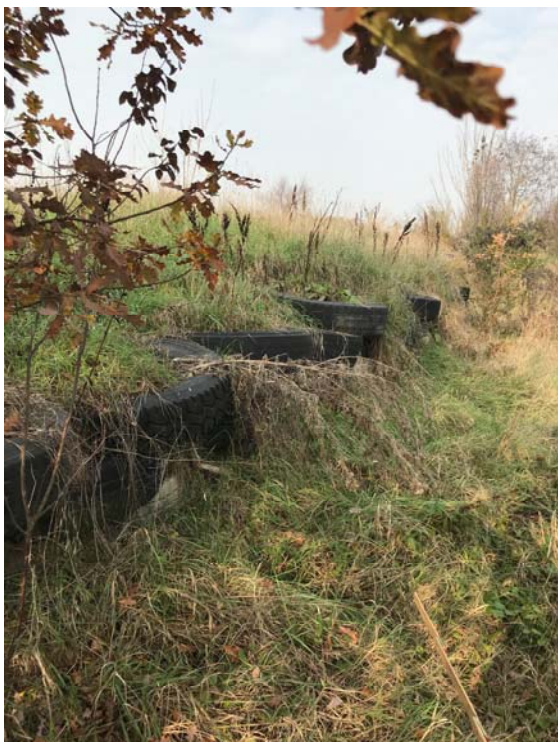
Copertoni da autocarro utilizzati a contenimento dei terrapieni
