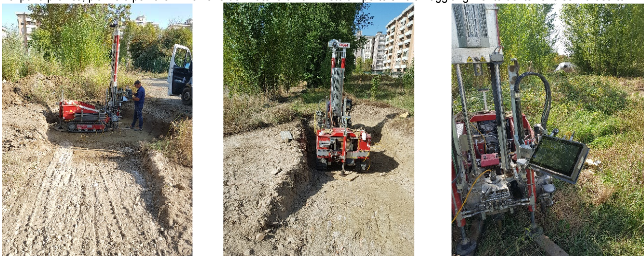
Fig. 9: Punti realizzazione delle Cpt_U e relative piazzole (da sinistra Cpt_U01, Cpt_U02 e Cpt_U03)
