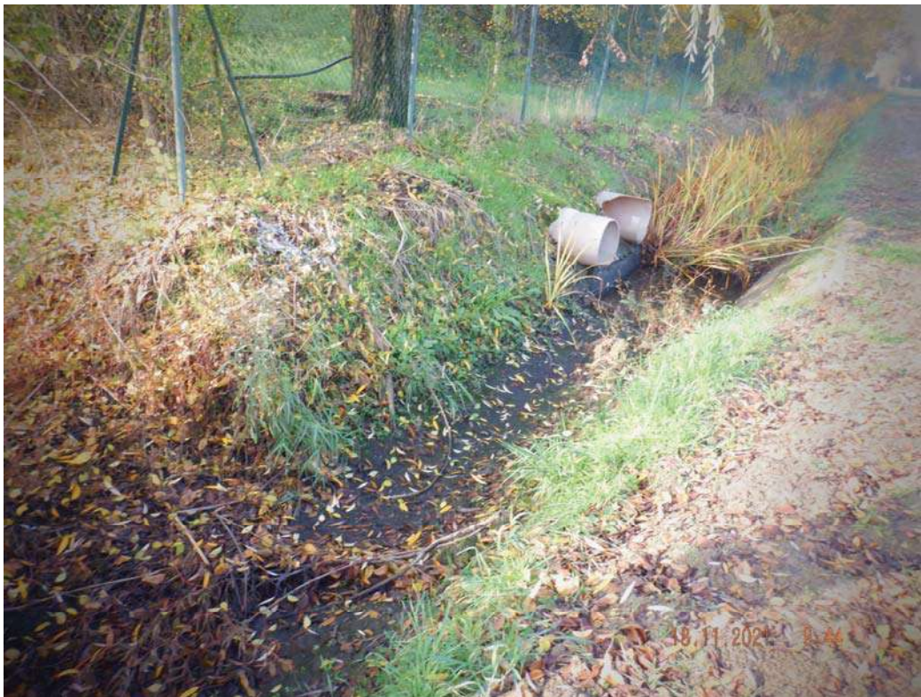
FIG. 9: ATTUALE PUNTO DI SCARICO ACQUE METEORICHE
