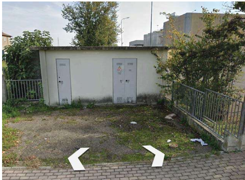
Fig. 3.43 – cabina di trasformazione secondaria MT/BT a servizio della cantina (ggogle street view)
