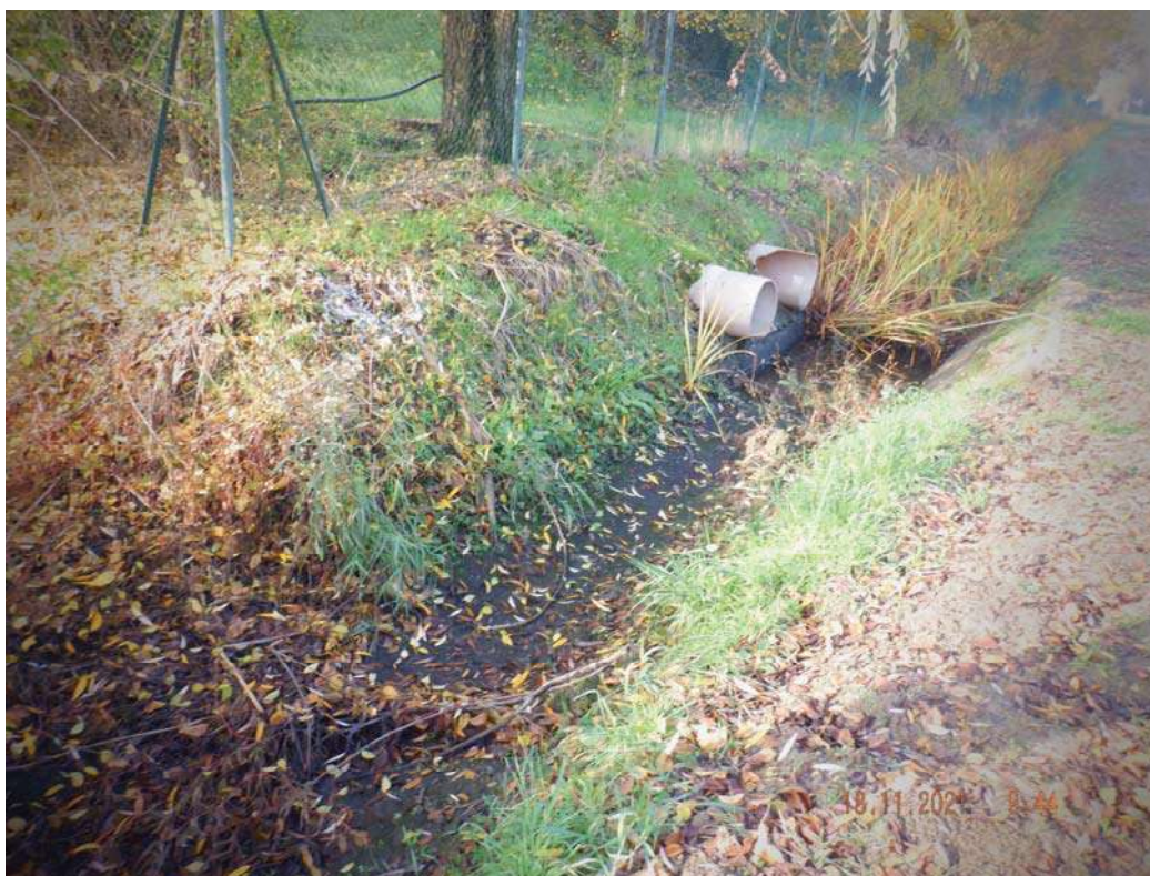
FIG. 9: ATTUALE PUNTO DI SCARICO ACQUE METEORICHE
