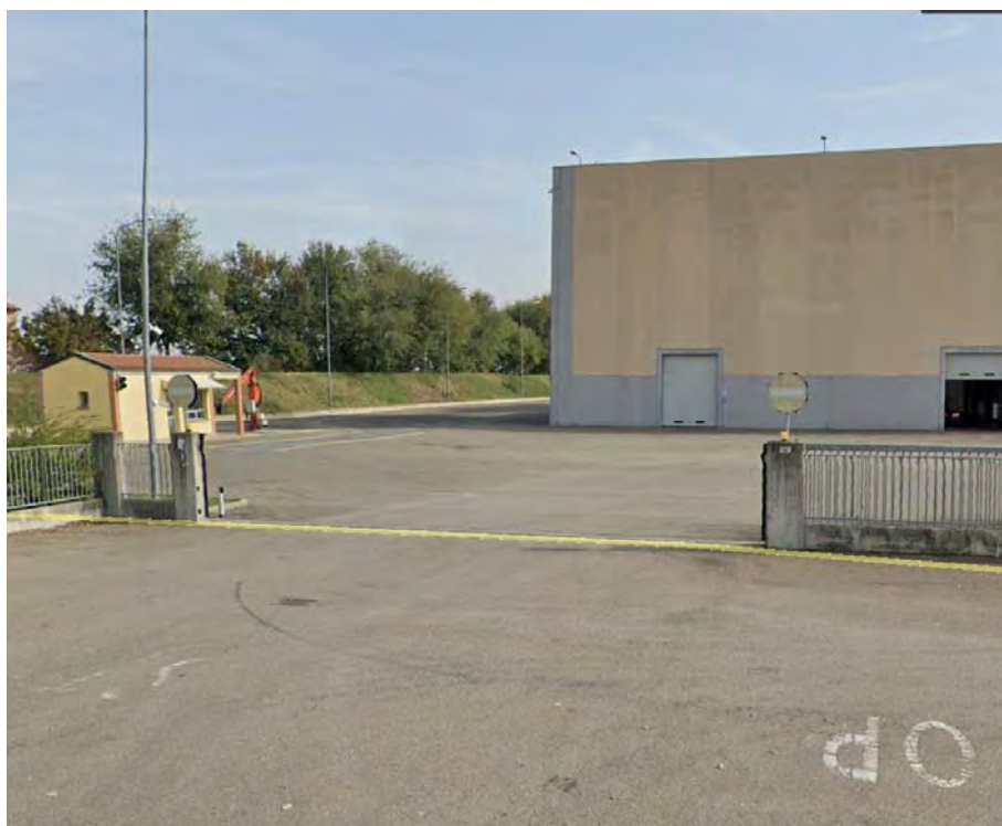
FIG 1.5- INGRESSO NORD SU VIA CAVATA , IN SECONDO PIANO BARRIERA A VERDE SUL CONFINE NORD
