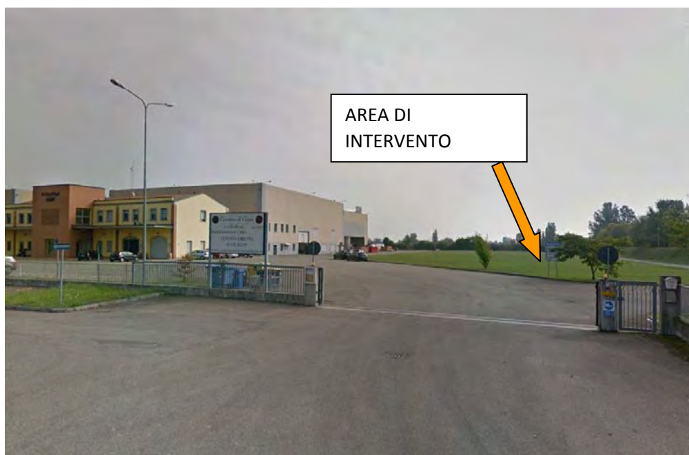
Fig. 3.3 - Street view - Vista area di intervento da Via Cavata EVIDENZIATA LA ZONA di MODIFICA DEL SUOLO
