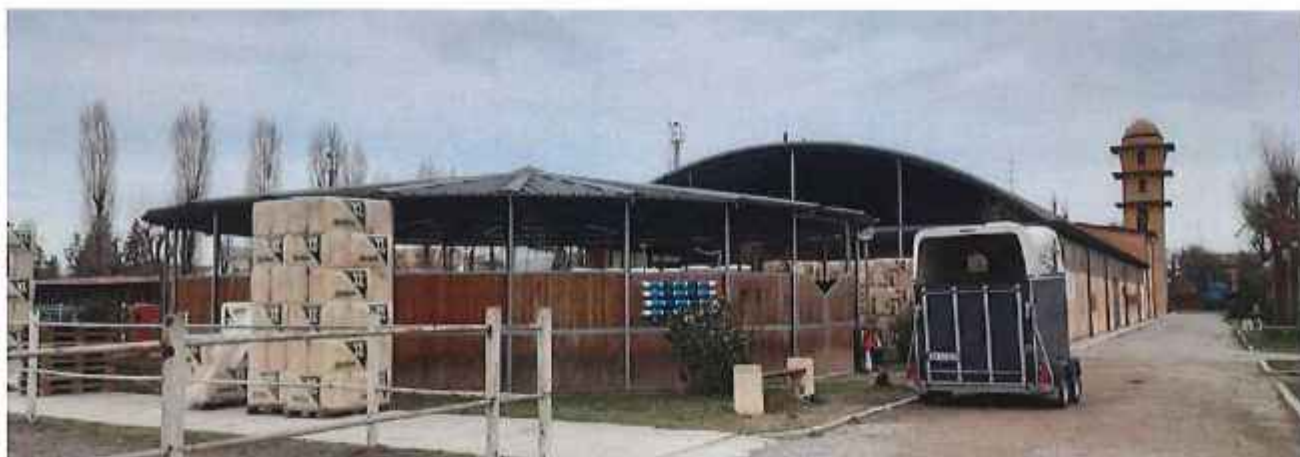
Visione delle caratteristiche del tondino (id. n. 5)
