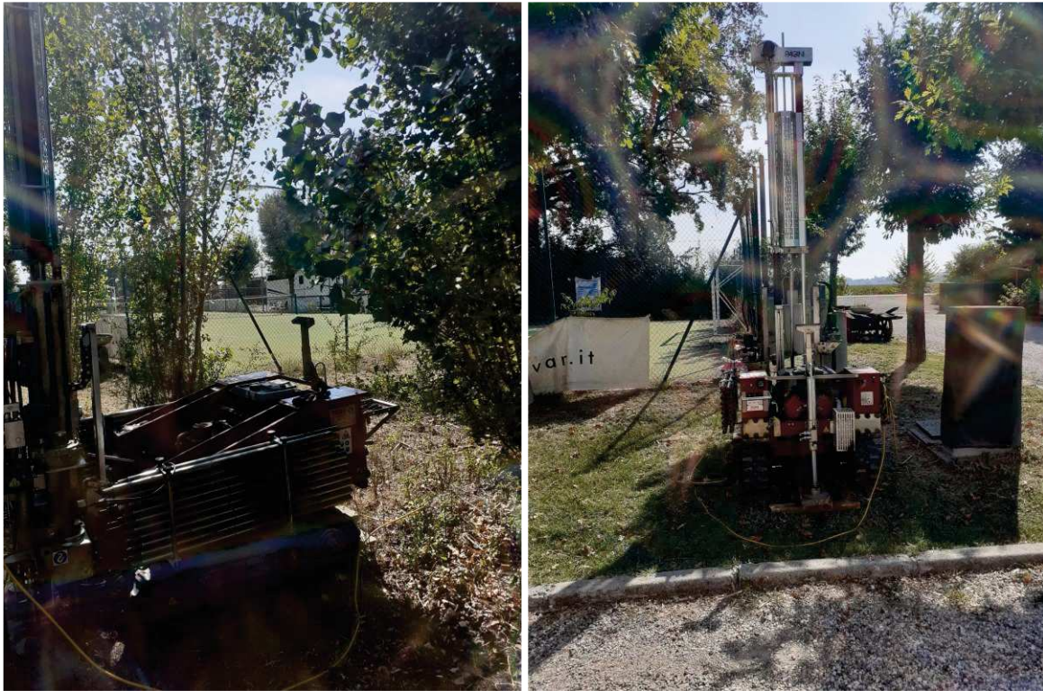
Figura 7: Esecuzione prove penetrometriche
