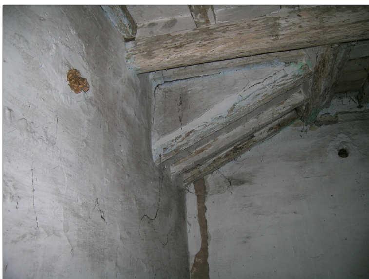
PARETE EST - SUD
