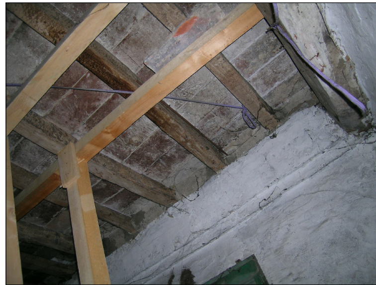
PARETE NORD - SOFFITTO
