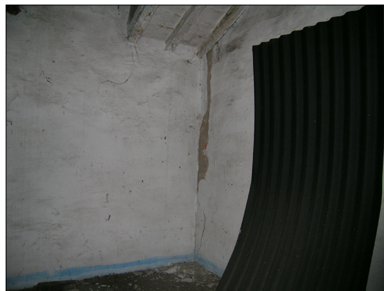
PARETE EST - SUD
