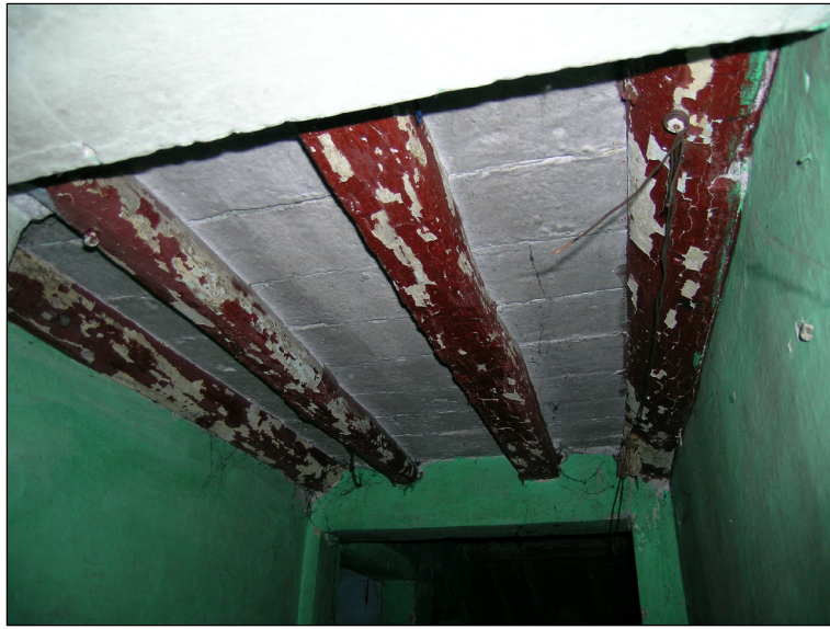
PARETE NORD – SOFFITTO
