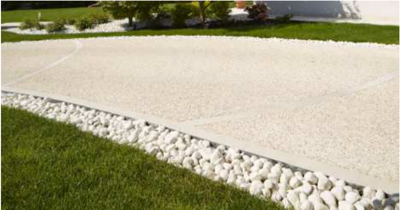
Figura 6 – Esempio di canaletto filtrante
