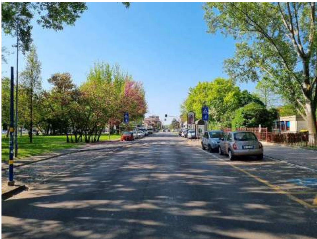
Figura 12 – FOCU 02_Tratto di via Remesina oggetto d'intervento
