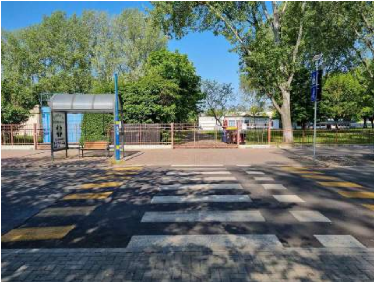
Figura 11 – FOCUS 02_Via Remesina_ particolare attraversamento pedonale oggetto d'intervento dal Parco verso il polo scolastico e fermata dell'autobus che verrà mantenuta
