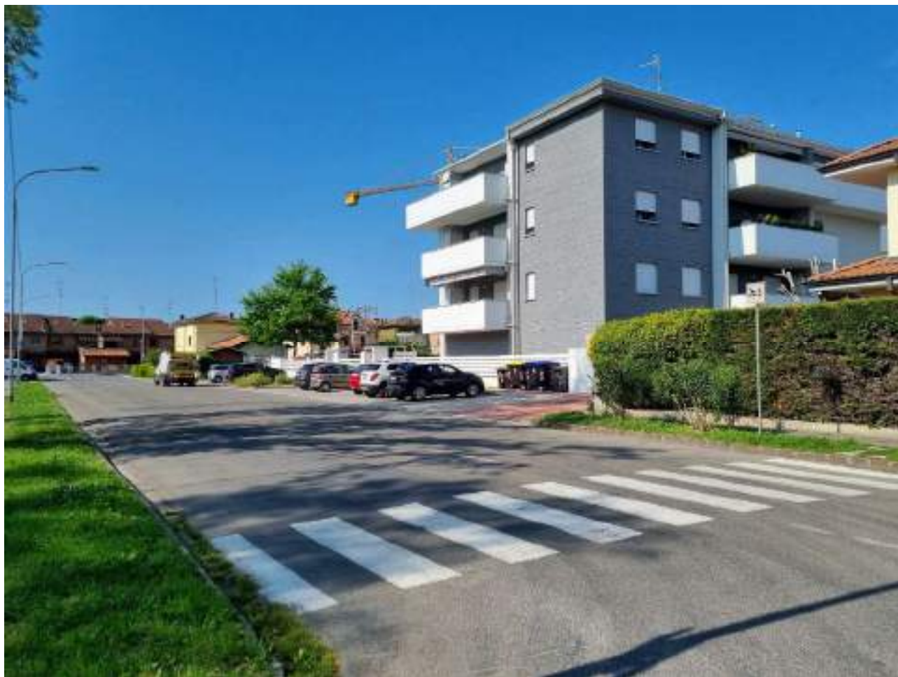
Figura 20 – FOCUS 03_Actuale attraversamento pedonale di collegamento con il verde pubblico
