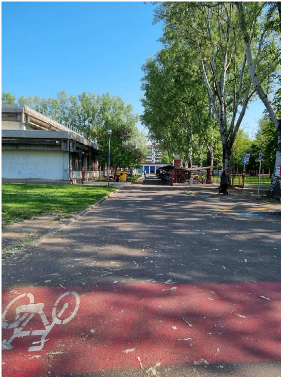
Figura 5 – FOCUS 01 _Particolare accesso carrabile alle scuole O. Focherini da Via Magazzeno oggetto di rifacimento
