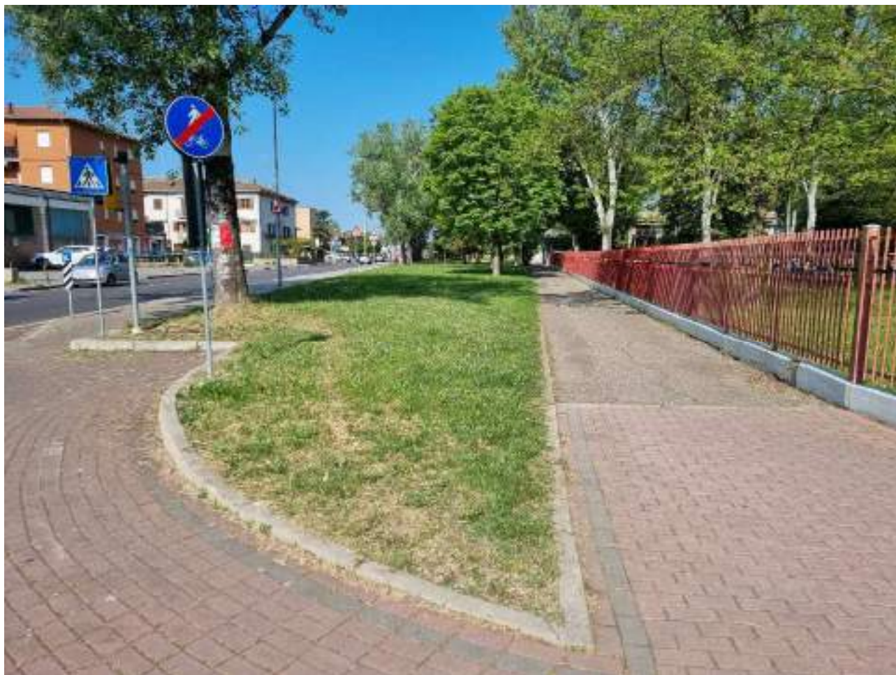
Figura 6 – FOCUS 01_Pista ciclabile oggetto di rifacimento e ampliamento
