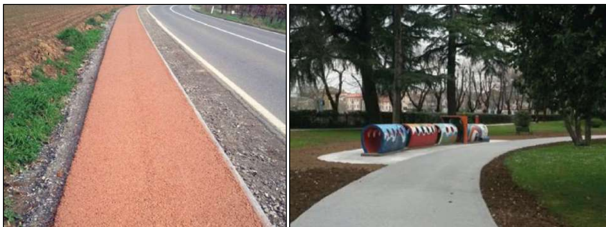
FIGURA 20: immagine tipo pavimentazione architettonica drenante
