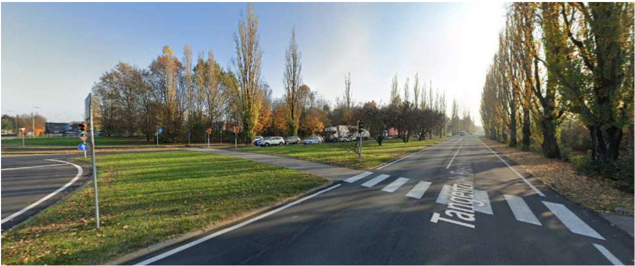
Vista area dell'attraversamento ciclopedonale sud
