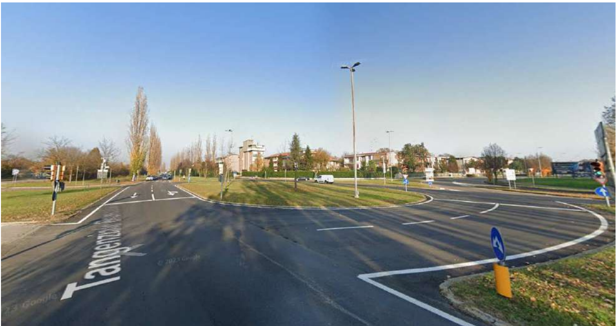
Vista dell'incrocio dal quadrante sud ovest
