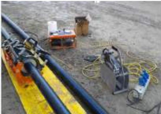
Foto 5 – Posizionamento saldatrice su superficie piana e regolare
