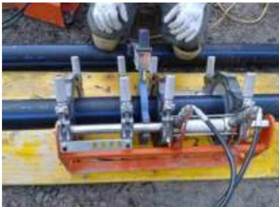
Foto 6– Posizionamento saldatrice su superficie piana e regolare
