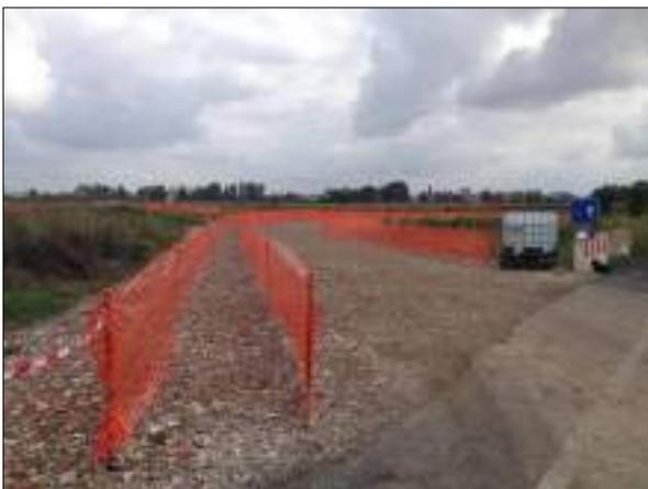
Foto 16 – Esempio pista di accesso al cantiere
