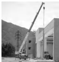
Autogrù impegnata nel montaggio di elementi prefabbricati
