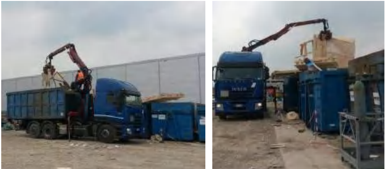
Foto 23 - riempimento del cassone a bordo mezzo con sollevamento materiali
