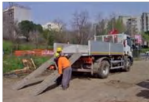
Foto 26 - Rimozione pedane mobili
