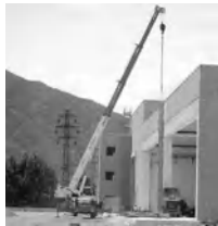
Autogrù impegnata nel montaggio di elementi prefabbricati
