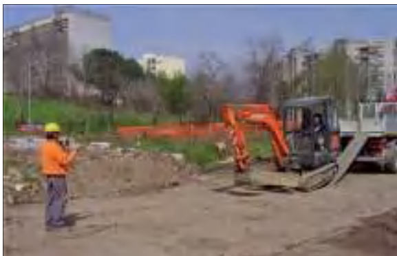
Foto 25 - Discesa di miniescavatore da pedane mobili
