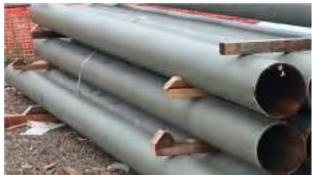
Foto 5: Stoccaggio corretto: stocchetti di legno tra i tubi per tenerli sollevati
