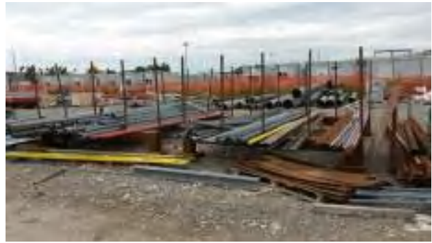
Foto 2: Stoccaggio corretto: tubi stoccati in griglia o rastrelliera
