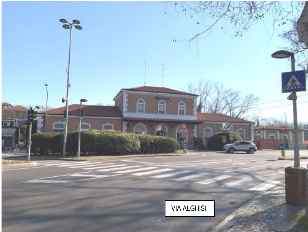
Vista da via Dallai lato ovest – aiuole di separazione tra viabilità principale e secondari alla Stazione, biforcazione corsia via alghisi, attraversamento pedonale a raso illuminato e regolamentato con imp. semaforico
