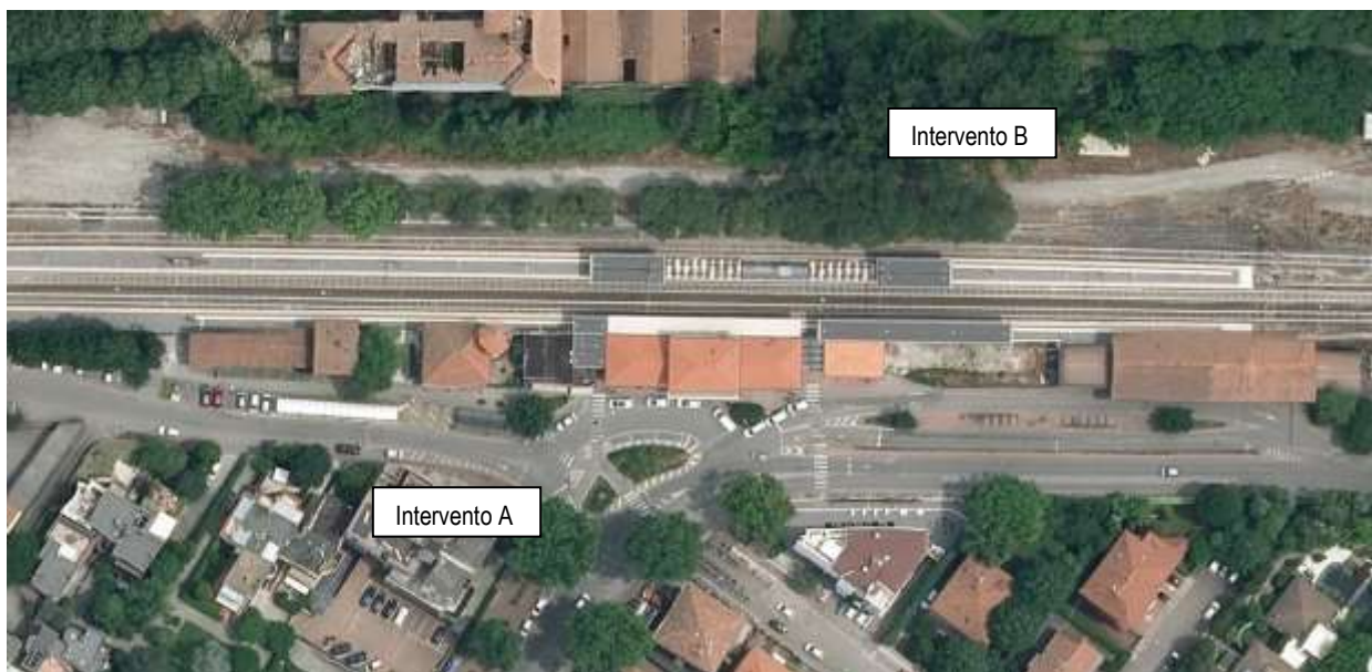
Vista aerea degli interventi
