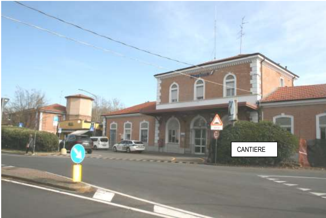
Vista da Via Alghisi lato sud/ovest – vista fabbricati, ingresso area taxi/sosta breve, isola di canalizzazione rialzata, zona 30
