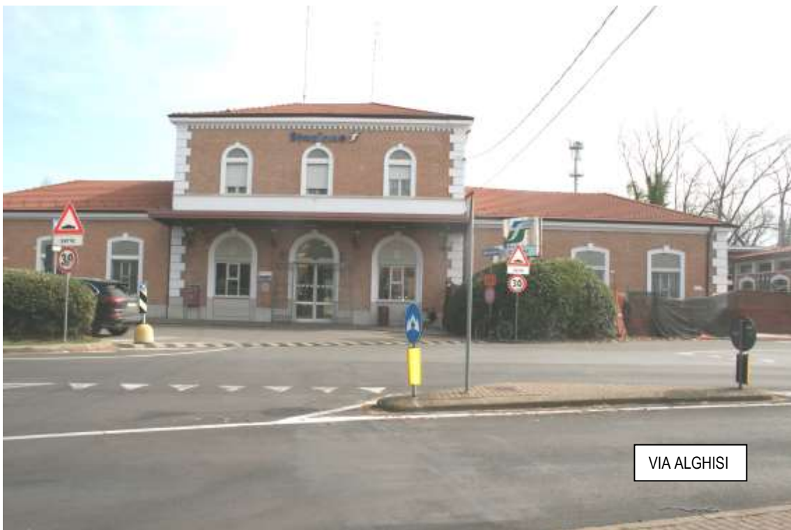
Vista da Via Alghisi lato sud/ovest – vista fabbricati, ingresso stazione, area di cantiere nuovo sottopasso
