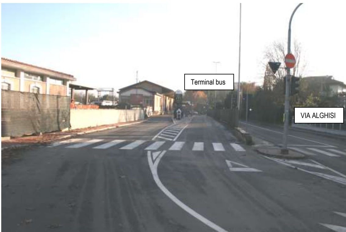
Vista del terminal bus – sulla sx cantiere nuovo sottopasso
