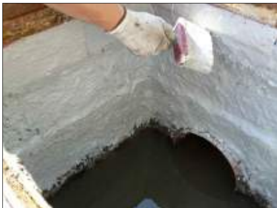
Foto 5 - Ripristino pareti e fondo con malta cementizia
