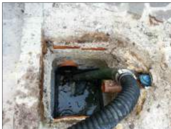
Foto 4 - Espurgo e lavaggio pozzetto
