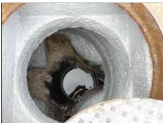
Foto 7 - Ripristino pareti e fondo con resina epossidica
