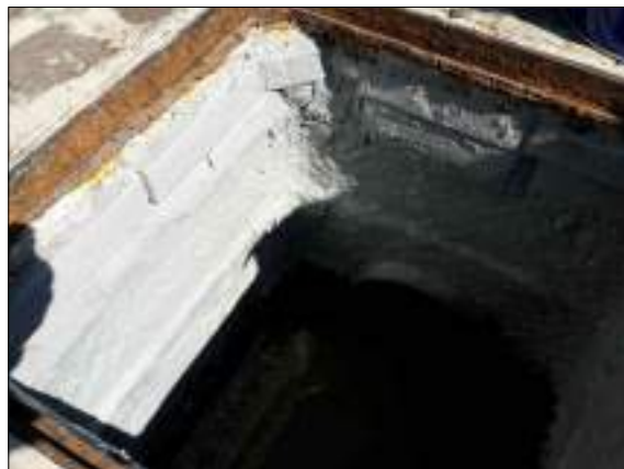
Foto 6 - Ripristino pareti e fondo con malta cementizia
