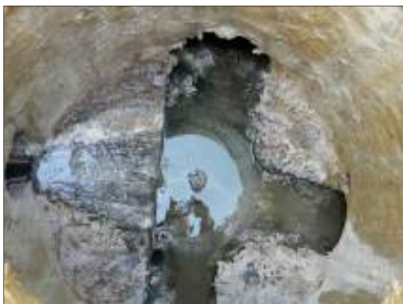
Foto 3 - Valutazione stato iniziale del pozzetto
