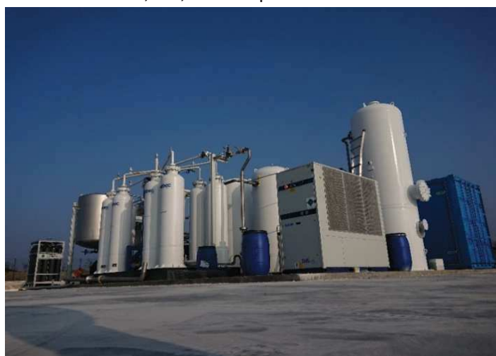
Figura 9: sezione di upgrading.
